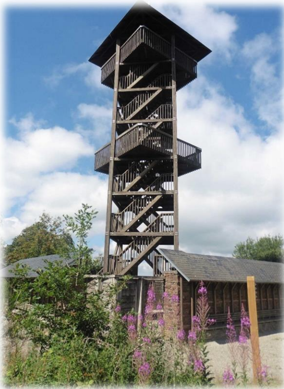
De uitkijktoren Fagne de Malchamps is van lariks gemaakt. De terras- en toegangsdeuren zijn gemaakt van eikenhout. Gelegen op een hoogte van 570 m, rust de toren, waarvan de basis
